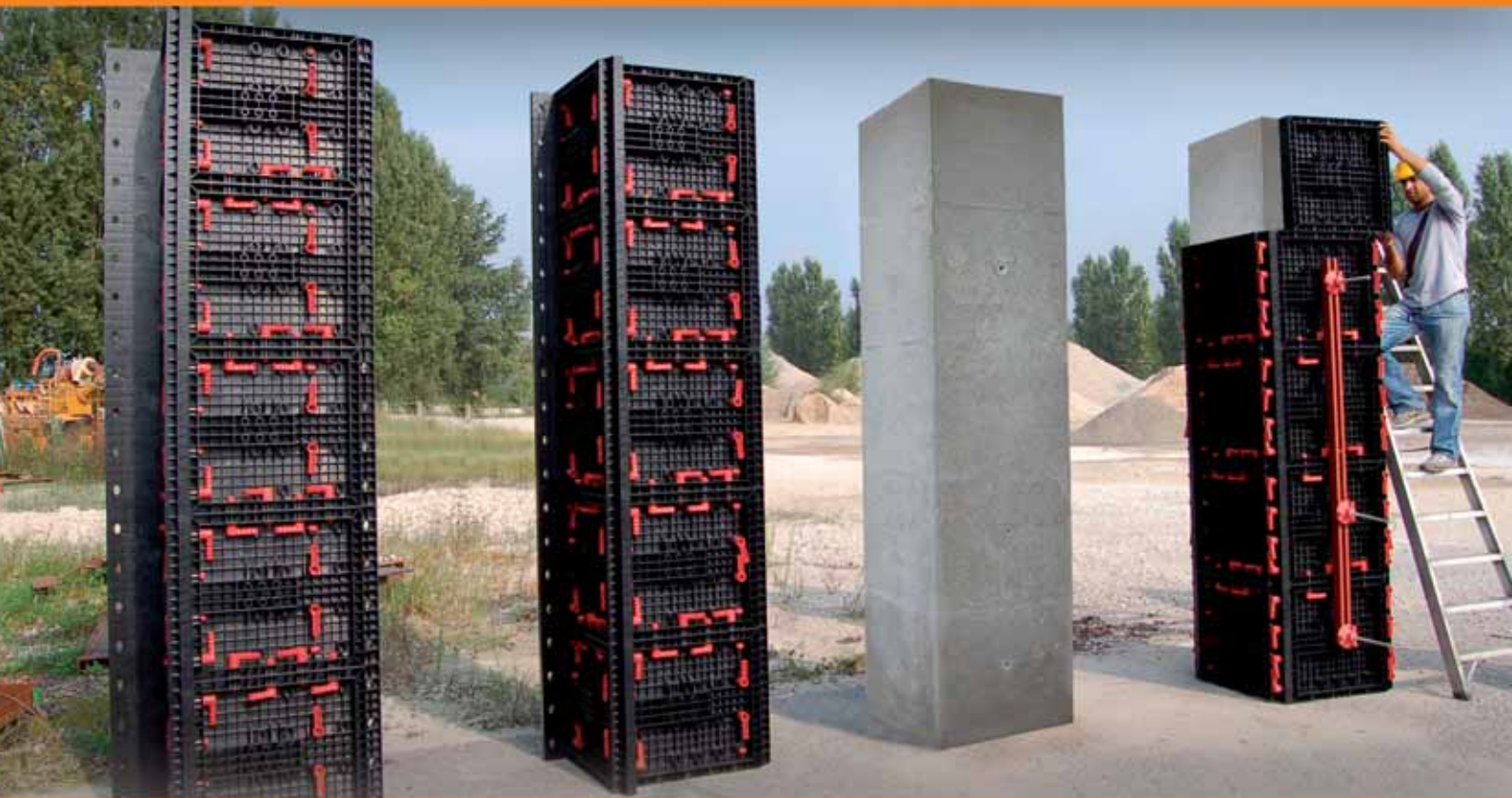
Универсальная многоуровневая опалубка для колонн
